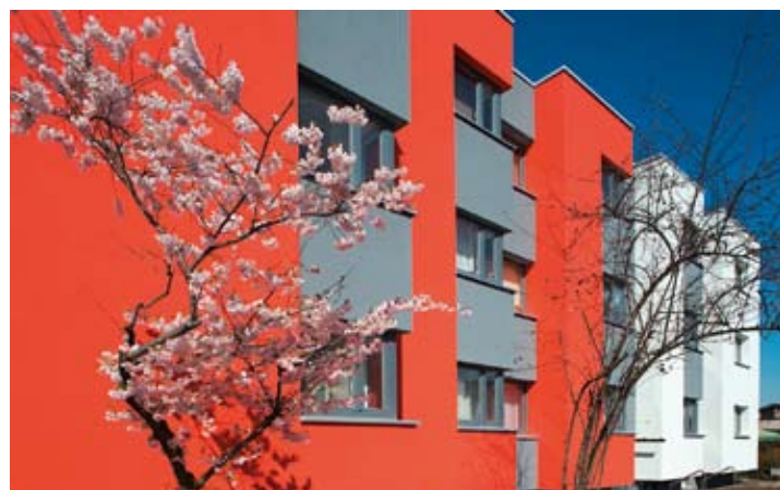
Bergheimer Str. 418 – 420: Fassaden-, Balkon- und Dachsanierung zur energetischen Optimierung
